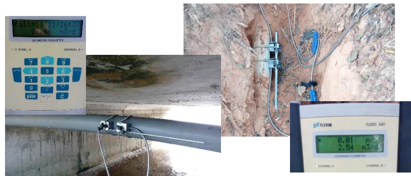
管線抓漏(金門水廠)
