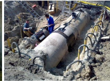
地下水泥管道
