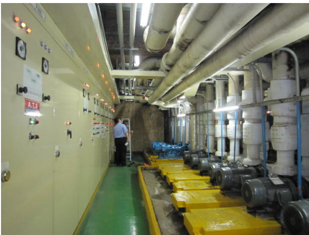
相片 3 空調系統檢測
