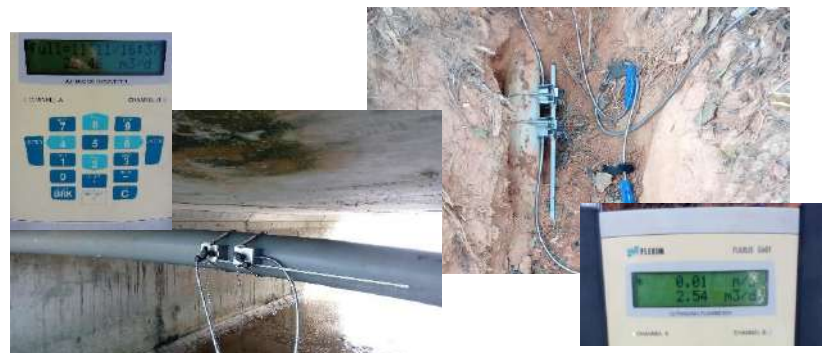
管線抓漏(金門水廠)
