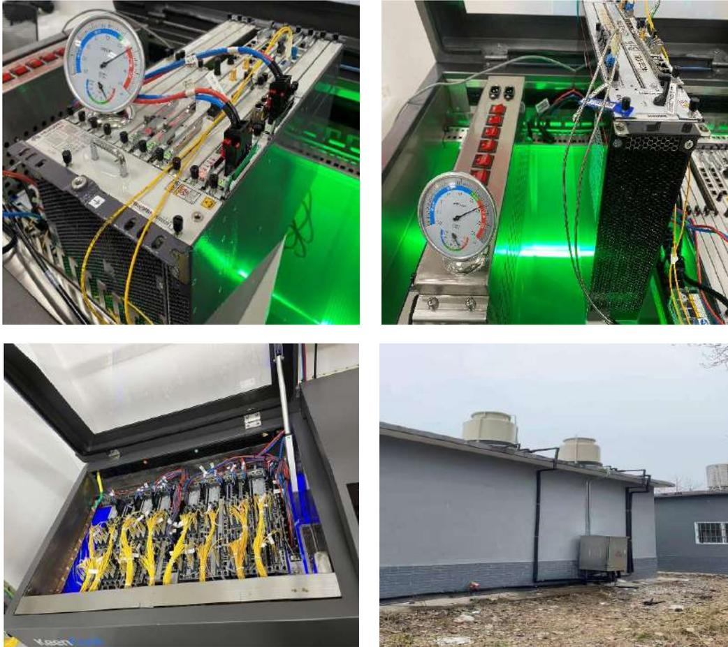
图4 中国移动汇聚机房单相浸没式液冷试点
