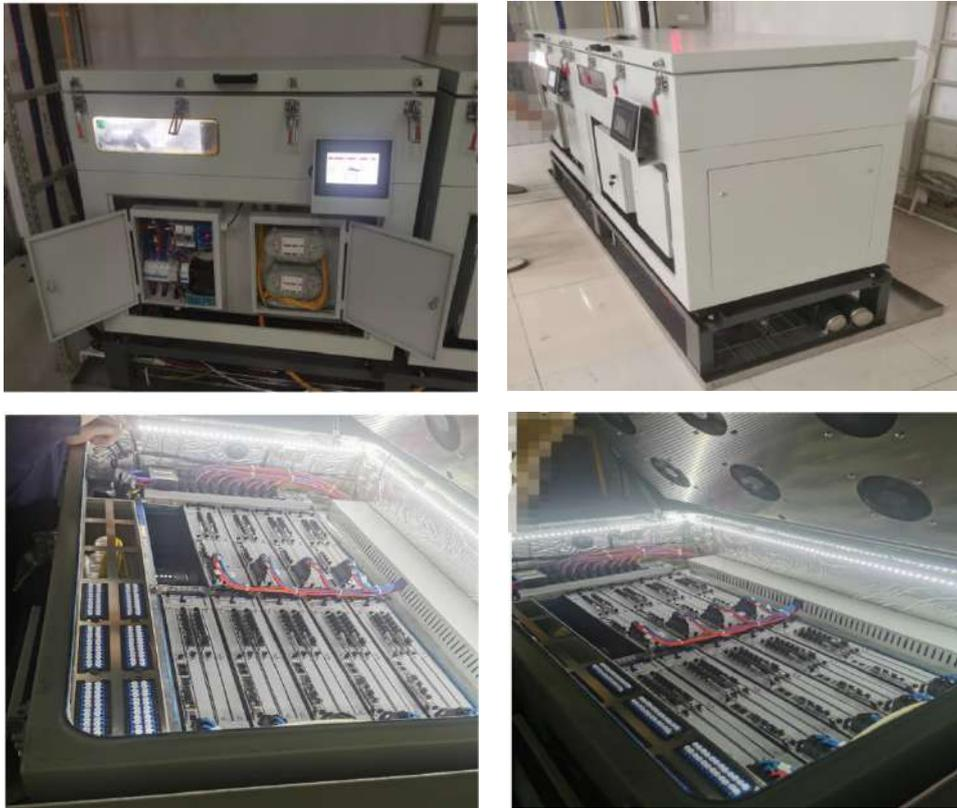
图 6 中国电信 5G BBU 机柜液冷试点
