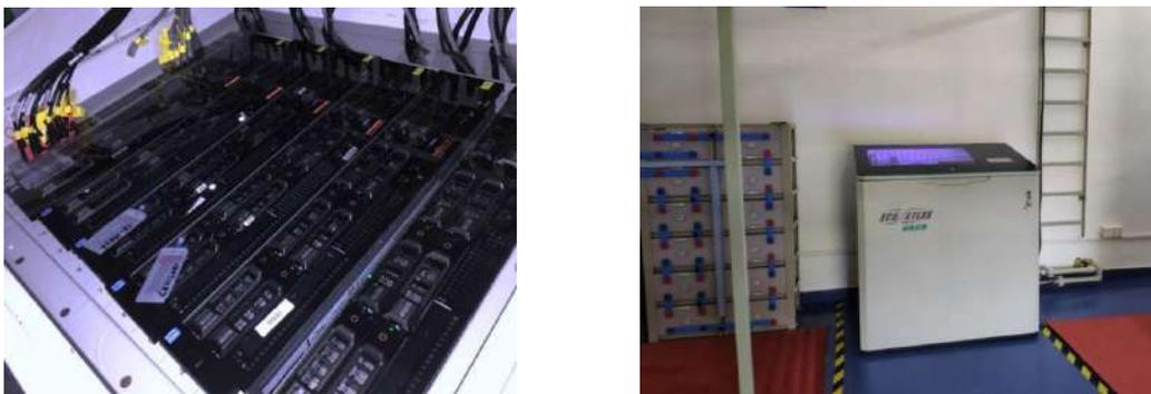
图3 中国移动5G基站单相浸没式液冷试点
