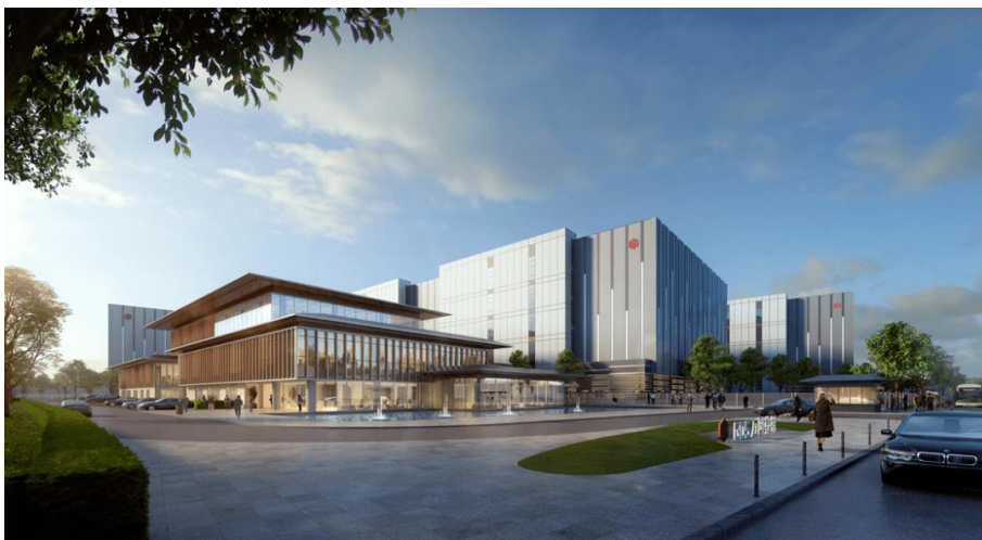
图 5.2 常熟某数据中心
