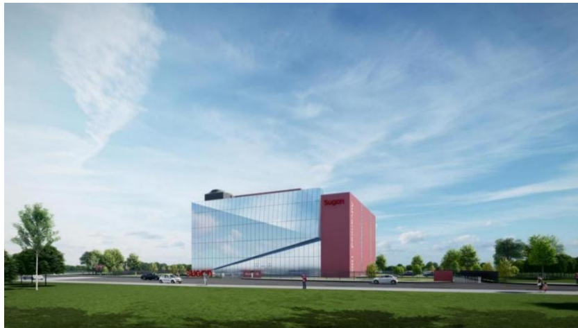
图 5.1 西部（重庆）某先进数据中心
