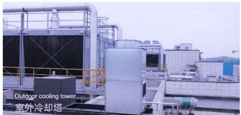
图 5-7 室外冷却塔
